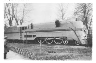
Экспериментальные паровозы, построенные по результатам опытов в аэродинамической трубе, показавших, что обтекаемый кожух способен увеличить скорость состава на треть, произвели большое впечатление на выставках.
