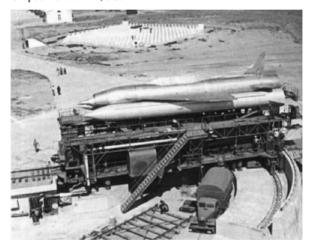
Межконтинентальная крылатая ракета — среднее между бомбардировщиком и ракетой. Стартовала «Буря» как ракета, затем включался новаторский прямоточный двигатель, и дальше она шла к цели по-самолётному, но автоматически, без пилота.
